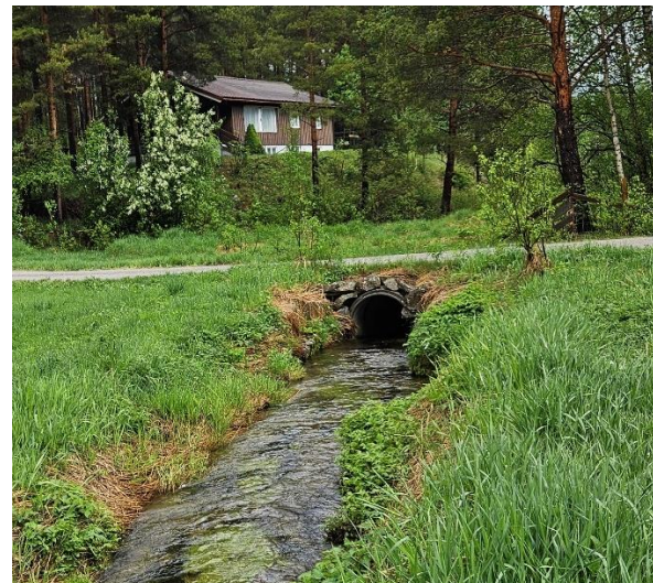
Figur 6: Stikkrenne under Augunetvegen (reg. punkt 9).
