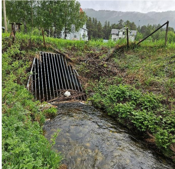
Figur 8: Kulvert under Hovsvegen (Rv. 50, reg. punkt 13).
